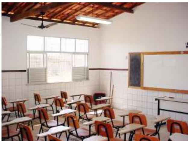
Ampliação do Colégio Estadual Moisés Bhoana
