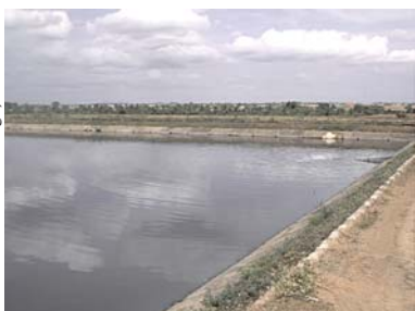
Foto 01 – Estação de Tratamento de Esgoto Sanitário
