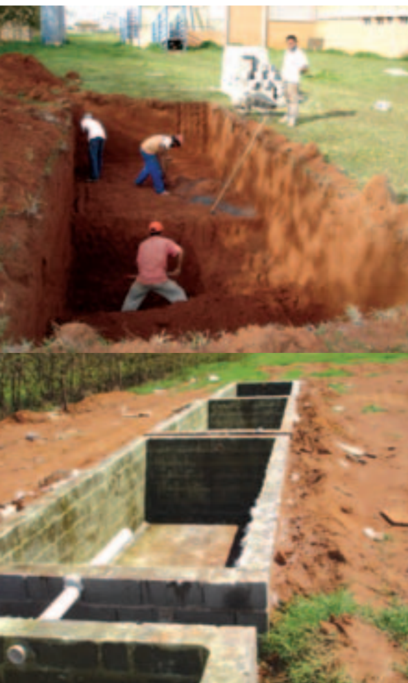
Etapas da construção do sistema de tratamento de efluentes
