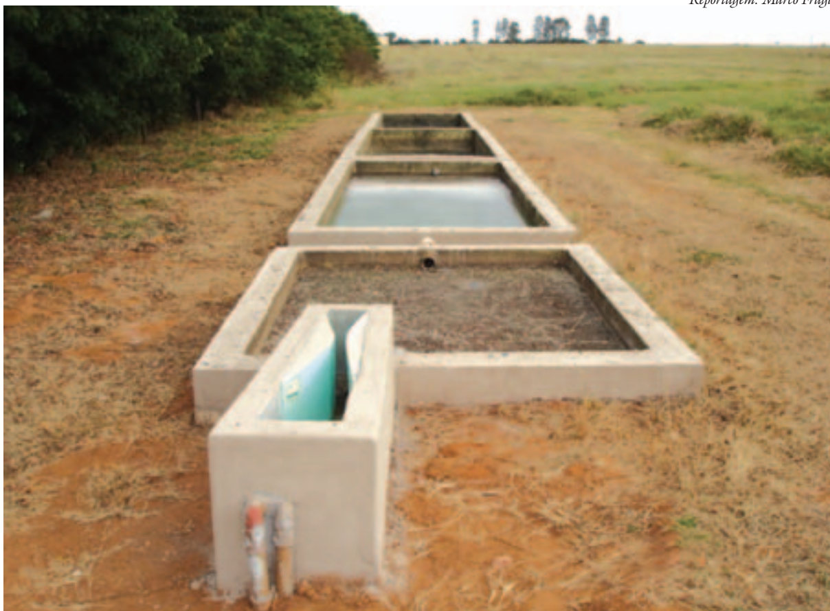
Etapas da construção do sistema de tratamento de efluentes
